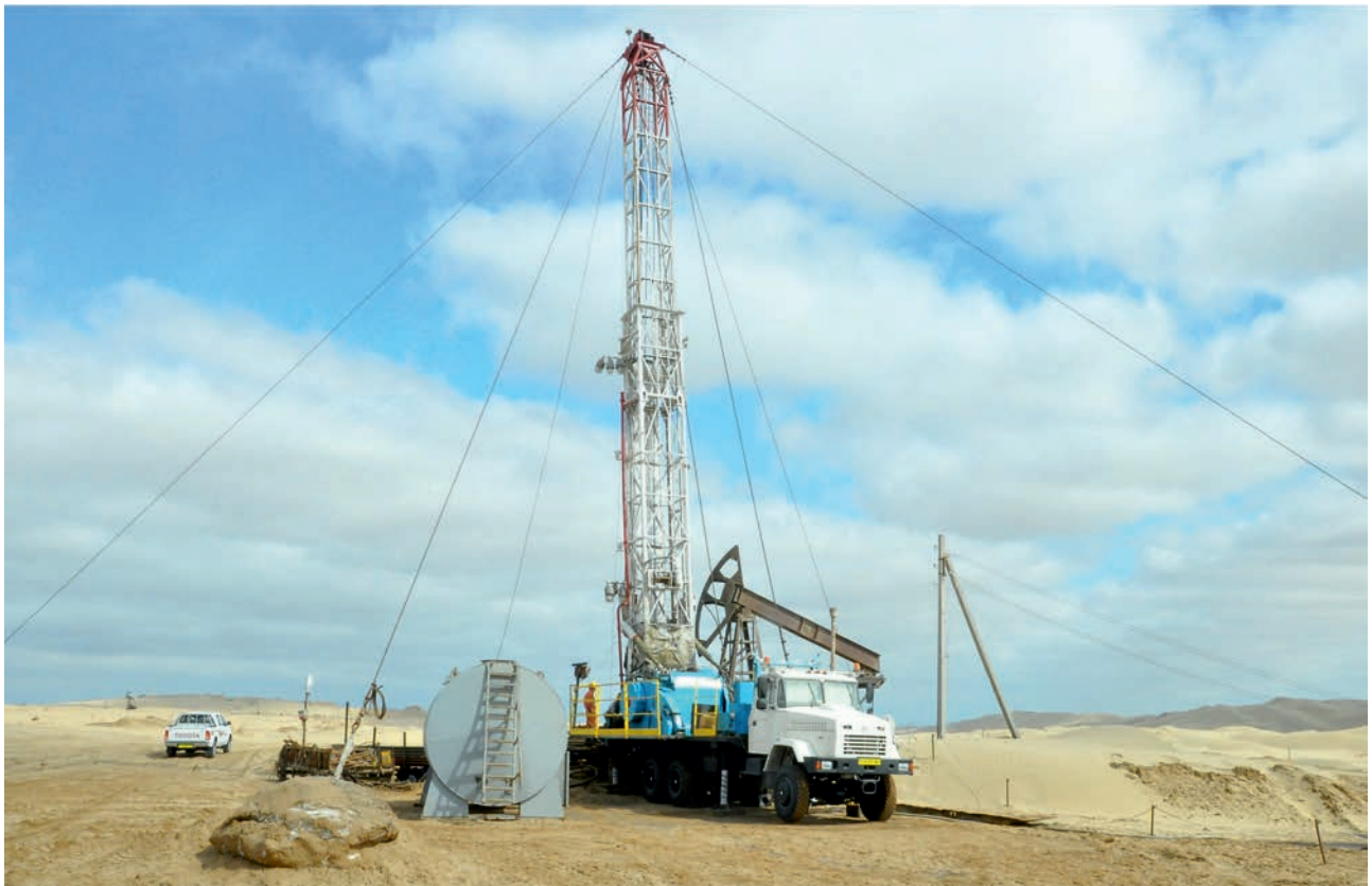
Месторождение Готурдепе: выполнение работ по ограничению водопритоков к забоя скважины с применением подъемной установки грузоподъемностью 80 т
