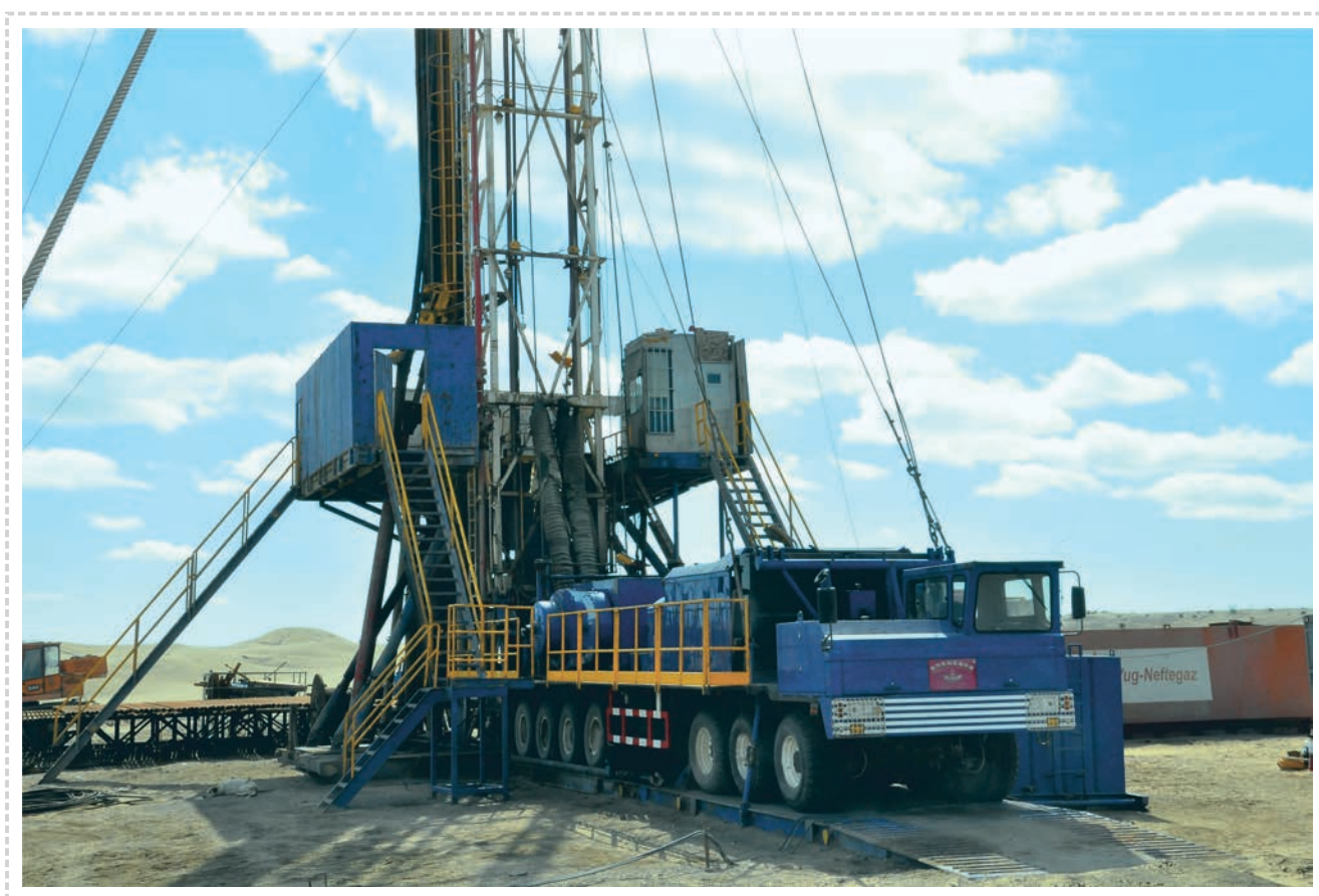
Месторождение Готурдепе: зарезка бокового ствола мобильной буровой установкой грузоподъемностью 225 т
