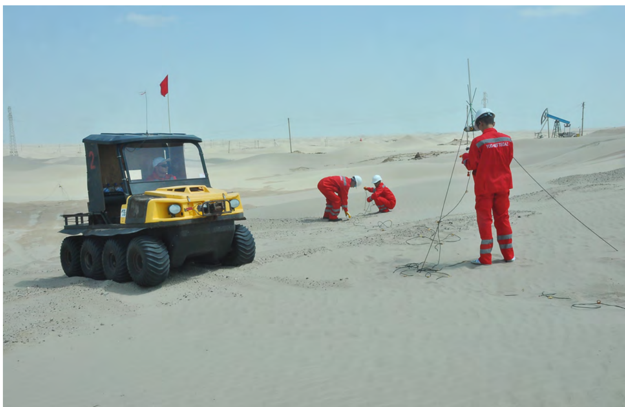
Месторождение Барсагельмес: Установка полевых модулей WRU беспроводной системы регистрации сейсмических данных RTS2 производства компании Wireless Seismic (США)
