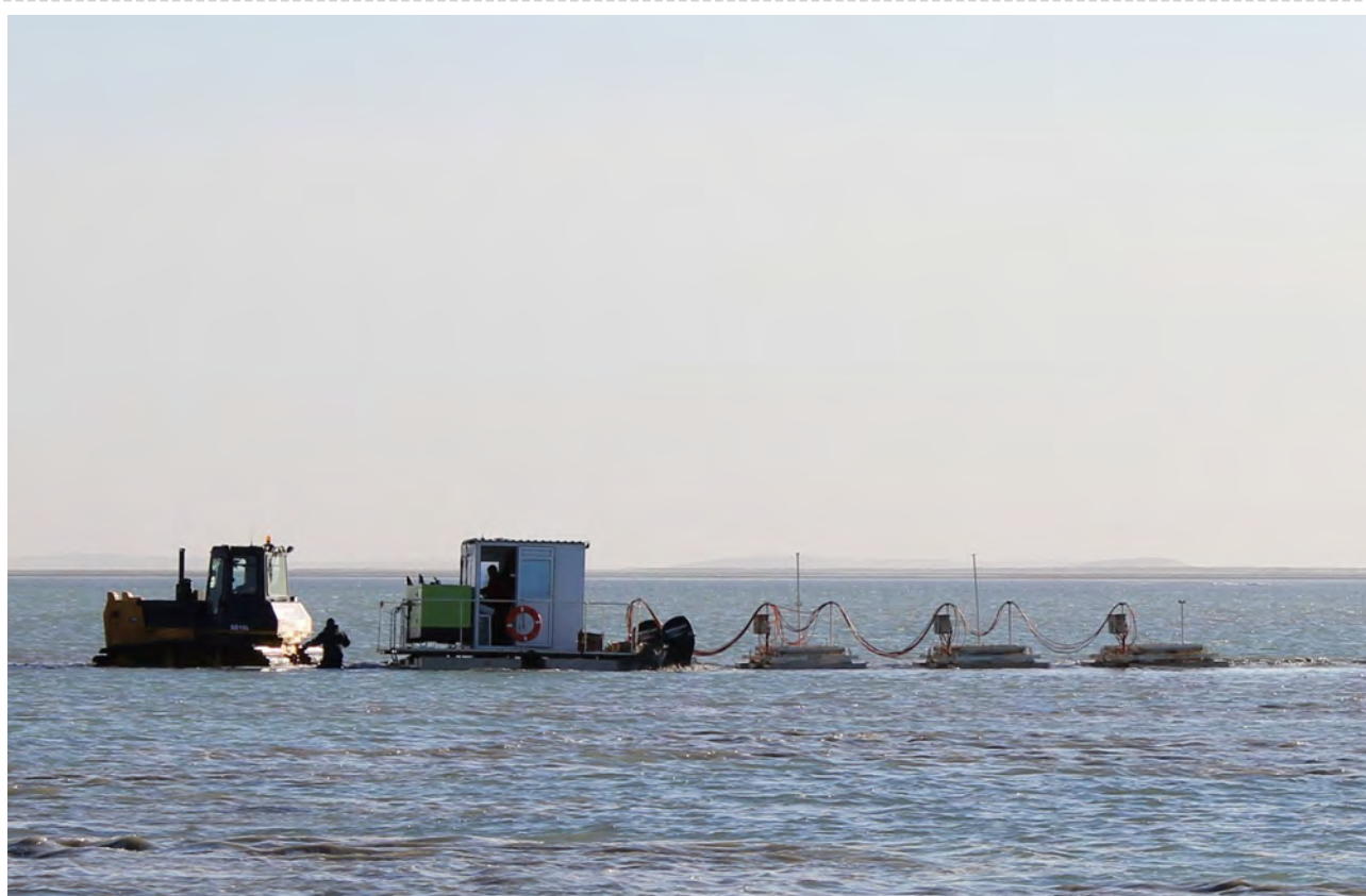
Полевые работы по 2D-сейсморазведке, включающей сушу и мелководье Каспийского моря в пределах залива Дарджа и южного склона Келькорского прогиба
