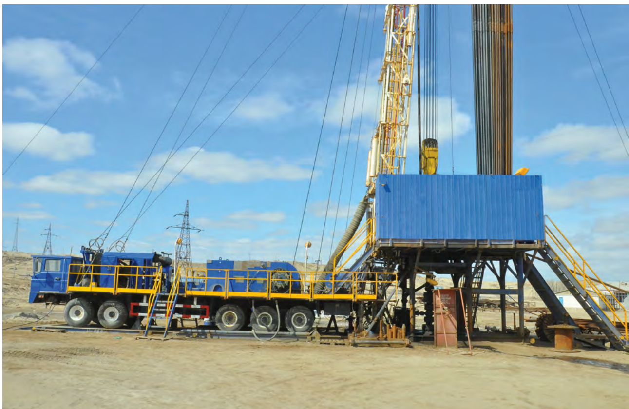
Месторождение Готурдепе: выполнение работ по капитальному ремонту в осложнённых условиях скважины с применением подъёмной установки грузоподъёмностью 125 т
