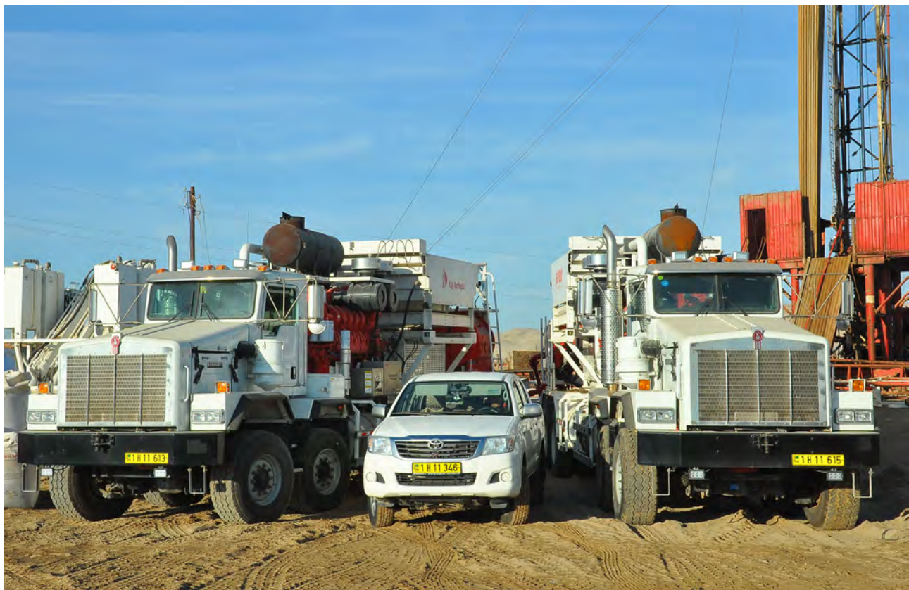
Месторождение Барсагельмес: выполнение работ по гидropескоструйной перфорации
