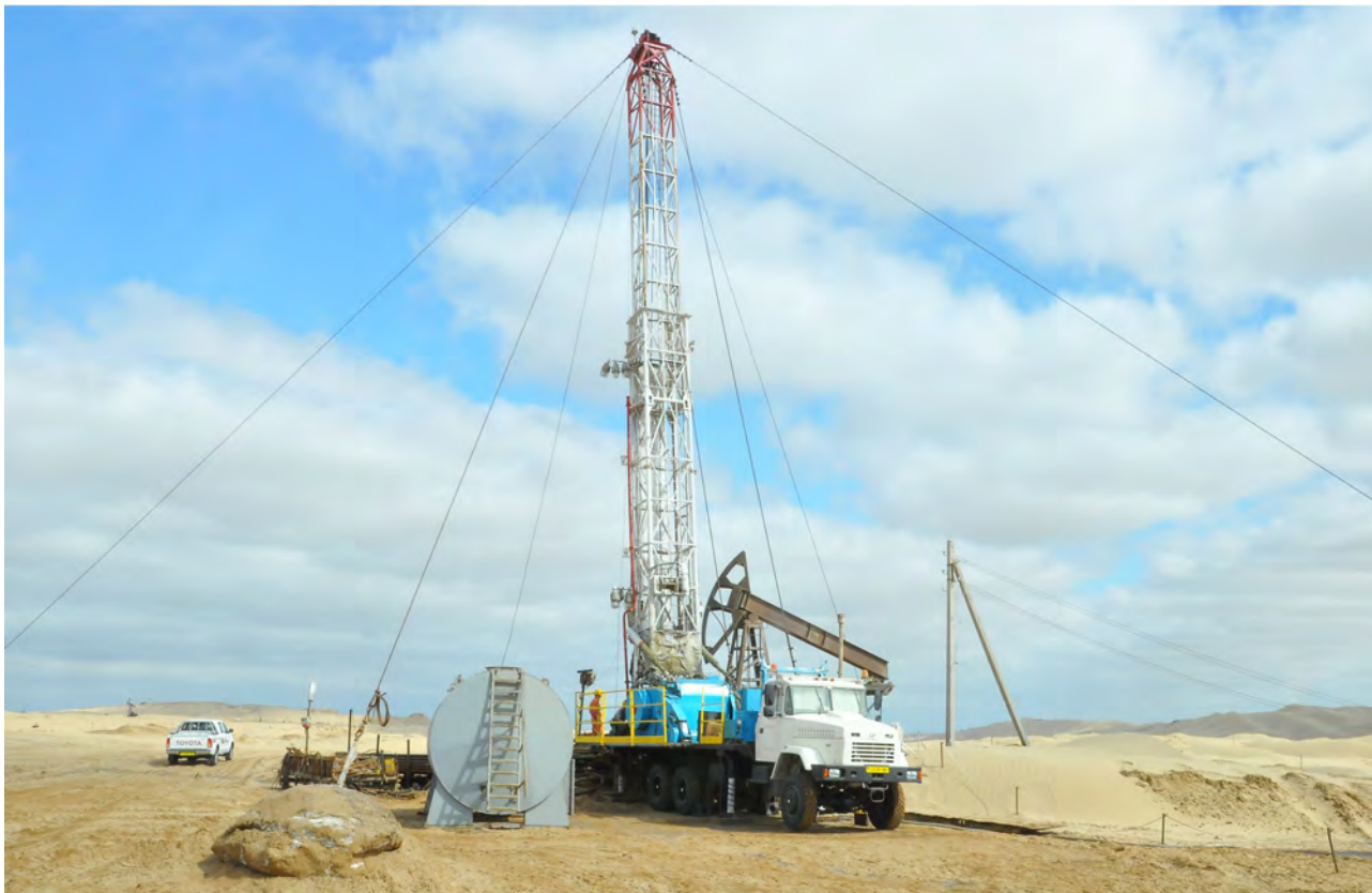
Месторождение Готурдепе: выполнение работ по ограничению водопритоков к забою скважины с применением подъемной установки грузоподъемностью 80 т
