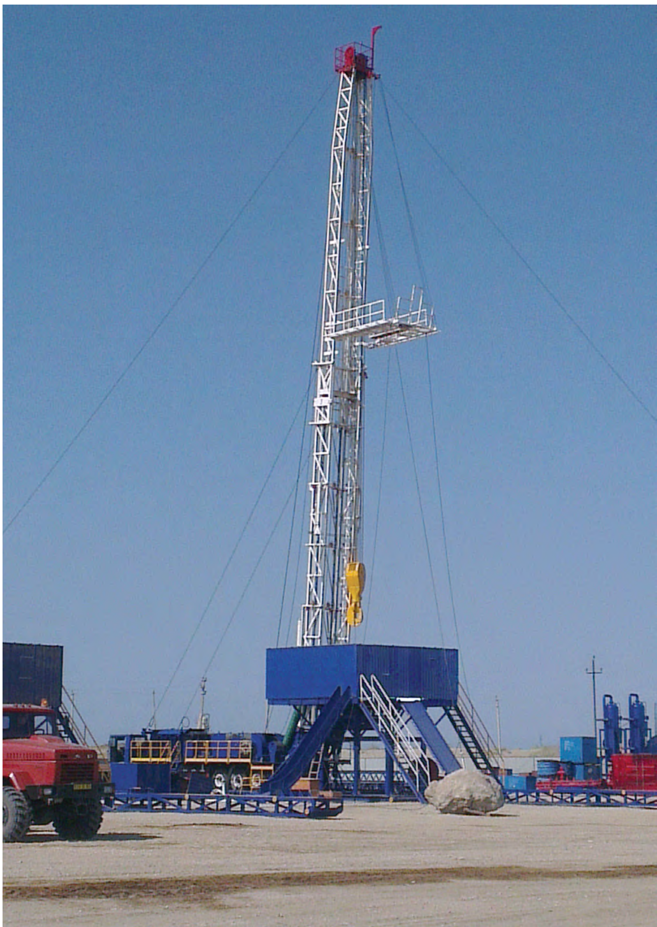
Месторождение Барсагельмес: выполнение работ по капитальному ремонту в осложнённых условиях скважины с применением подъёмной установки грузоподъёмностью 225 т
