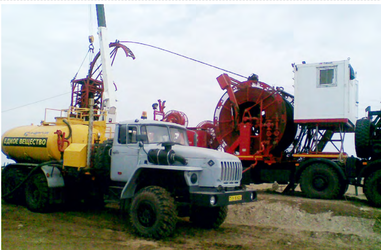
Месторождение Готурдепе: выполнение работ по кислотной обработке пласта с помощью колтюбинговой установки и насосной установки в кислотном исполнении.
